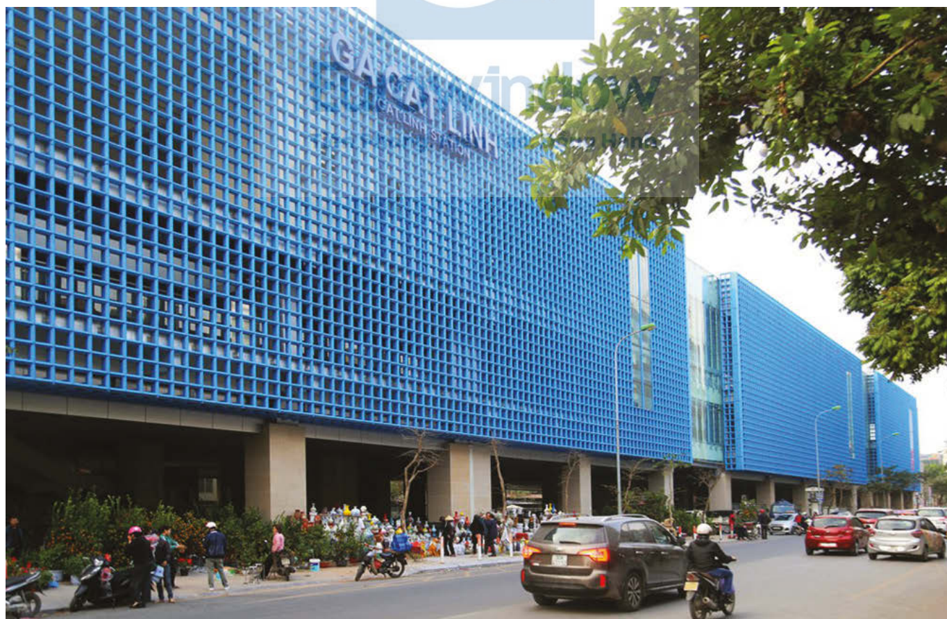
NHÀ GA ĐƯỜNG SẮT CÁT LINH - HÀ ĐÔNG
